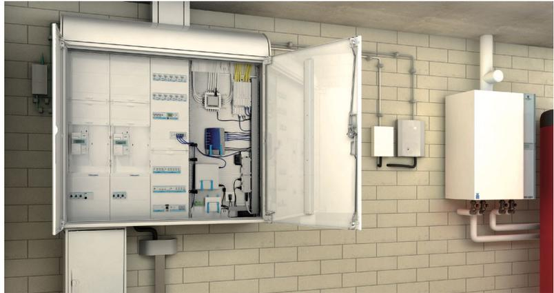
Bild 5: Moderner Zählerschrank mit elektronischen Elektrizitätszählern (Smart Meter) und zusätzlichen Kommunikationseinrichtungen
